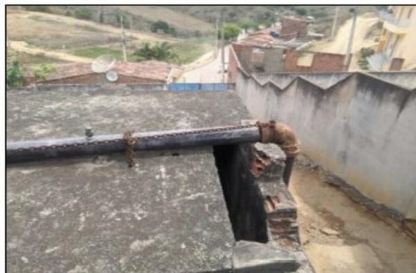
Figura 10 – Tubulação de chegada de água da EEAT Orobó, em más condições de conservação.
