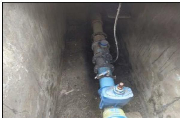
Figura 14 – Detalhe para a macromedição do reservatório.
